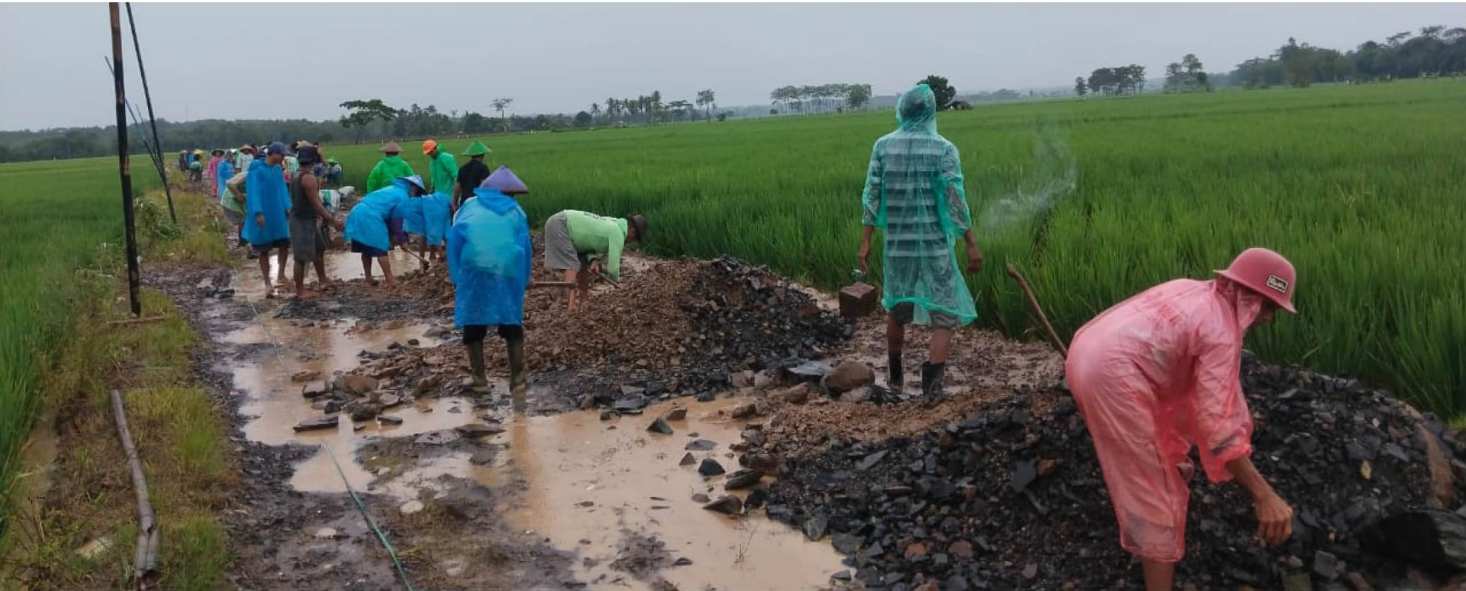
GOTONG ROYONG. Warga Kampung Kalapa Cagak, Desa Teluklada, Kecamatan Sobang, Kabupaten Pandeglang, sedang gotong royong memperbaiki jalan rusak penghubung 3 kecamatan di Kabupaten Pandeglang, Senin (12/1).
